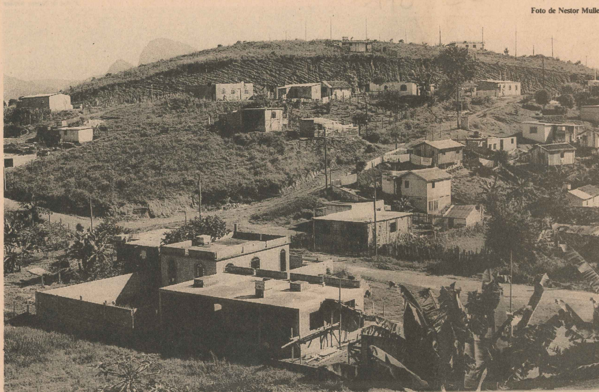
Em Campo Grande, Cariacica, nos lotes irregulares, muitas casas de alvenaria já foram erguidas pelas famílias
