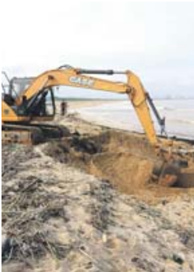
MÁQUINA durante obras na praia
