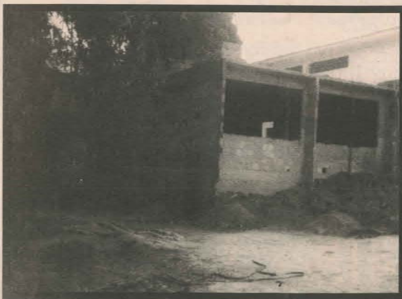
Ampliação da Escola de 1º e 2º Graus Aldy Soares Merçon
