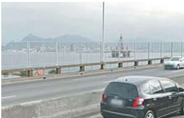
NA PONTE RIO-NITERÓI, grades foram instaladas para proteger áreas como o Cais do Porto e sobre uma base naval.
