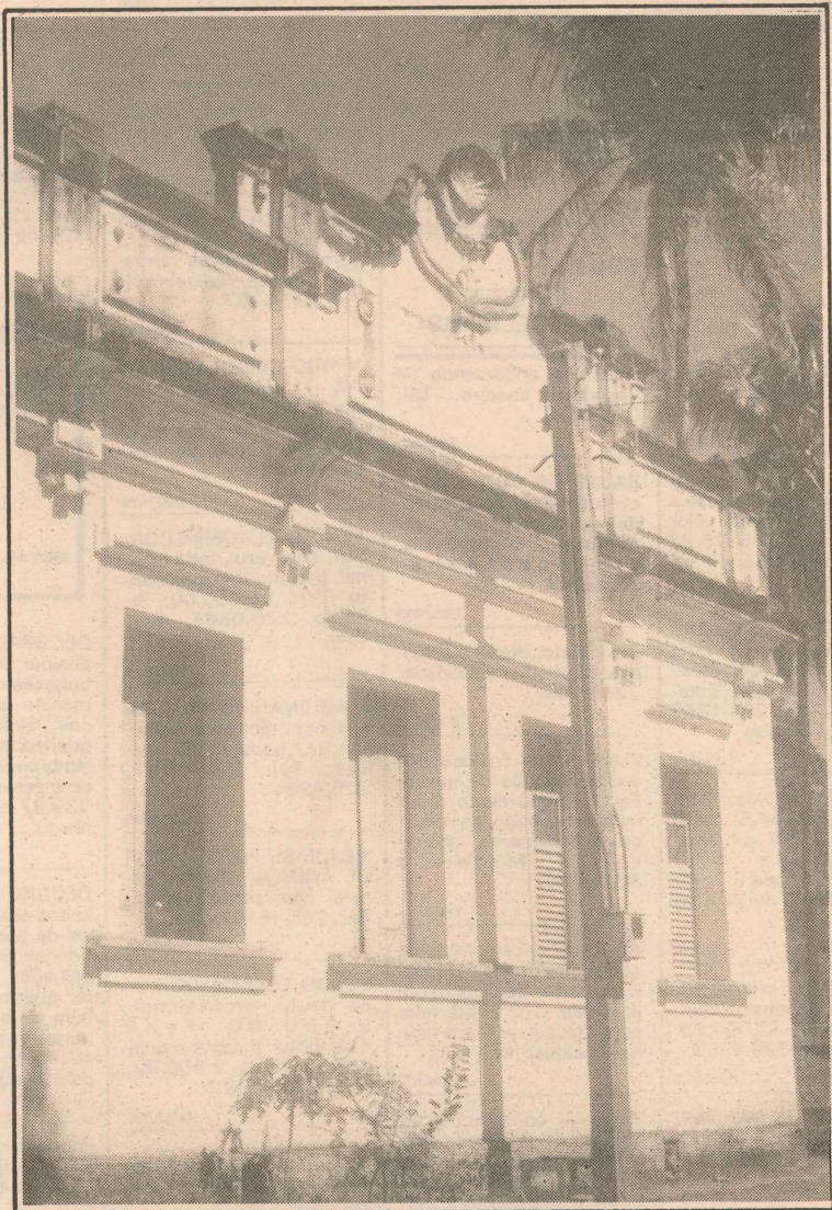
Toda a arquitetura da região guarda os traços da colonização italiana
