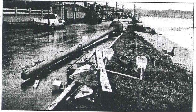
Poste de iluminação no chão durante a interdição das pistas
