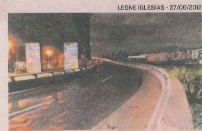
TRECHO mal iluminado na 2ª Ponte
