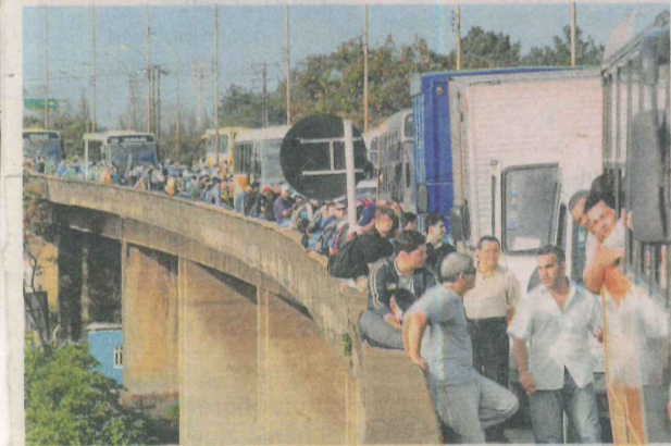
PASSAGEIROS descem dos ônibus durante engarrafamento na Segunda Ponte: riscos
