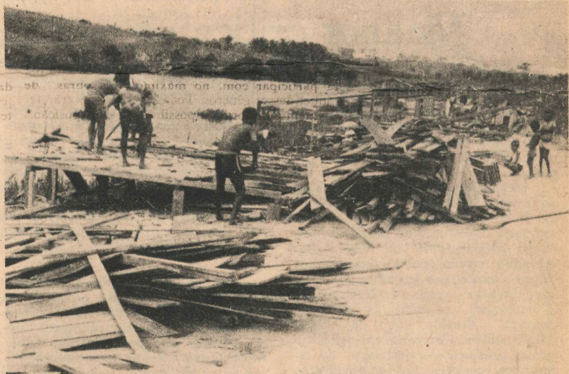
Mais 10 barracos serão derrubados hoje
