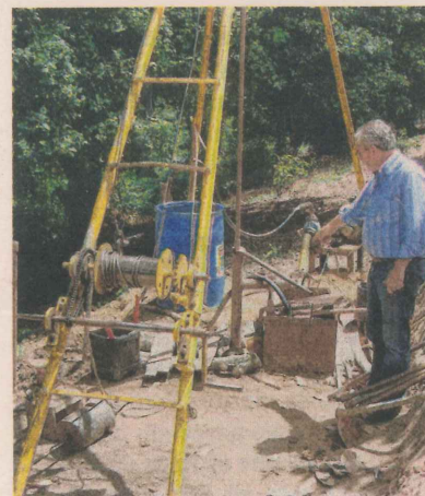
SONDAGEM do solo é feita na área
