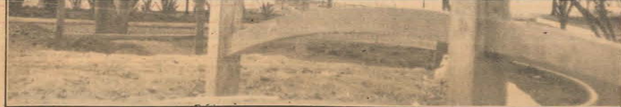
A Praça 22 de Agosto precisa de reparos e se encontra semi-abandonada
