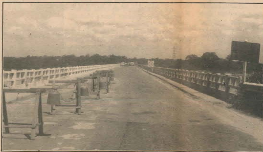
A ponte ficou interditada durante alguns meses para reparos necessários
