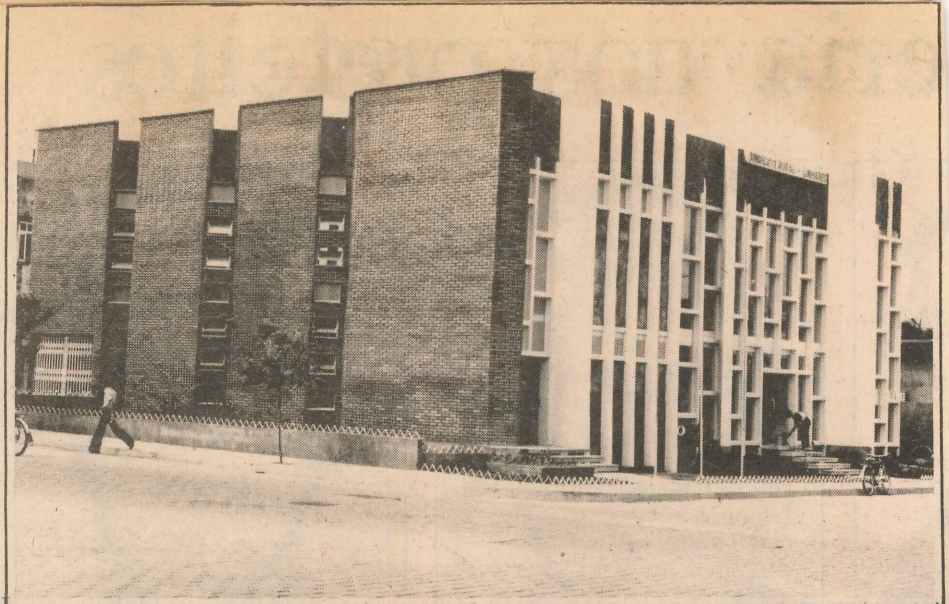
O prédio do Sindicato Rural Patronal de Linhares foi construído com a colaboração da Ceplac
