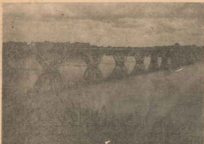
A ponte Getúlio Vargas, que faz a ligação da rodovia federal sobre o rio Doce, foi construída em 1950 e inaugurada pelo presidente que lhe emprestou seu nome.
