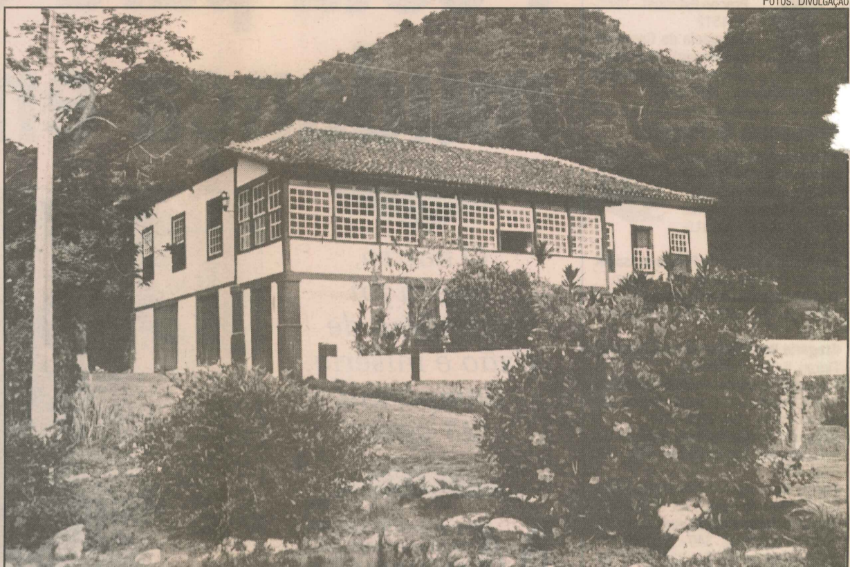
Fazenda Santa Rita, em Muqui: conjunto arquitetônico se destaca por diversidade
