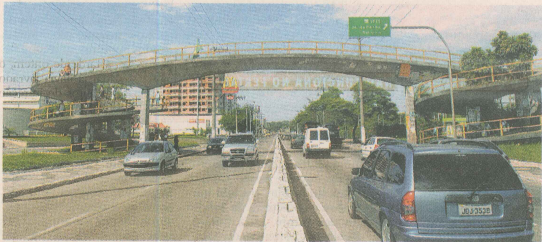
OUTRO ACESSO. A passarela usada pelos estudantes para ter acesso ao campus da Ufes será demolida e dará lugar a outra estrutura. FOTO: GILDO LOYOLA
