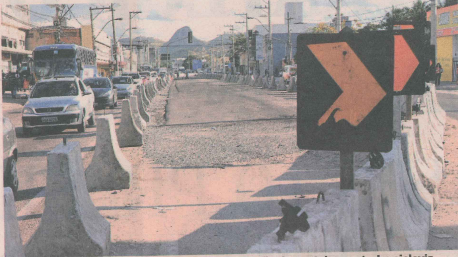
Faltam 400 metros de asfaltamento e delimitação de canteiro central e ciclovia
