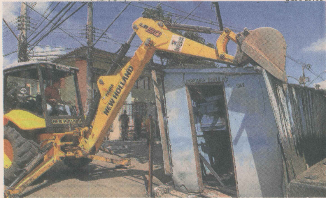
DESAPROPRIAÇÃO. Ontem foi demolida a barbearia de Tolentino Pinto, que funcionava havia 40 anos
