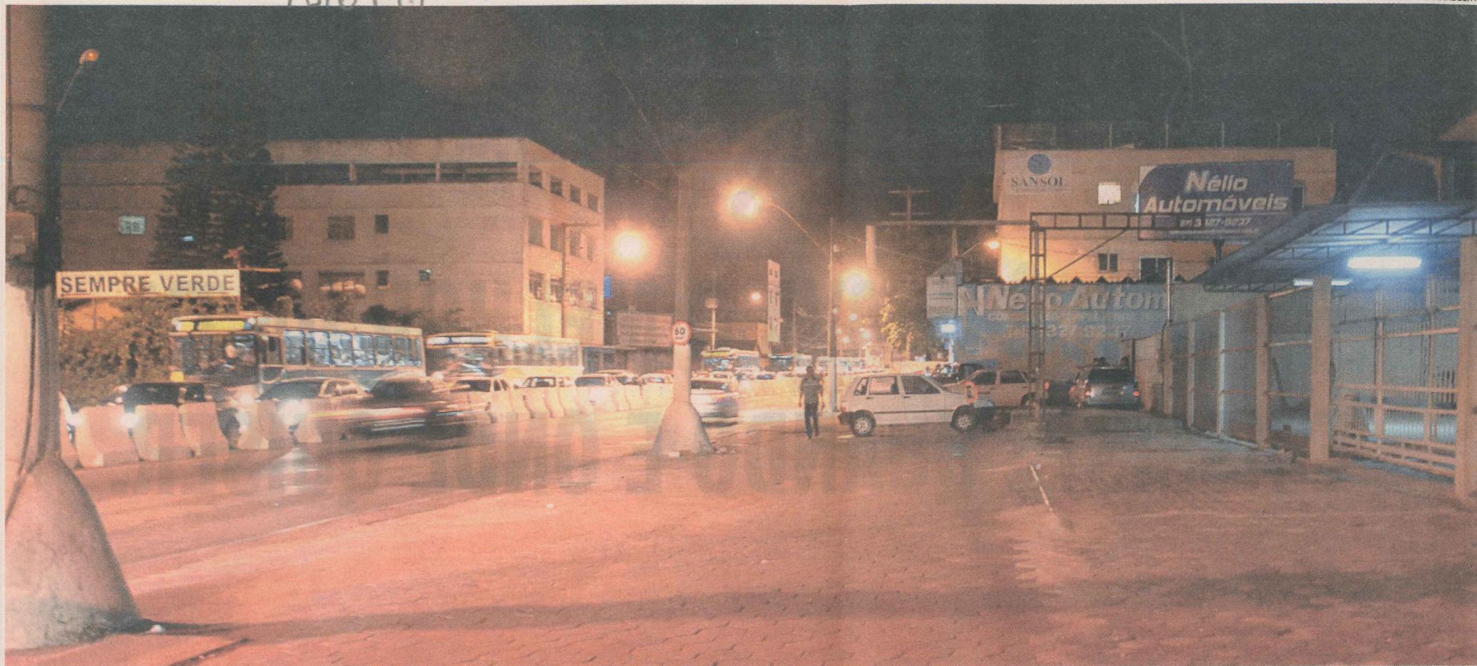
ÁREA DE UM DOS ESTABELECIMENTOS na avenida Fernando Ferrari que já se adequaram para o início das obras de ampliação da via, recuando da beira da pista para dentro do terreno
