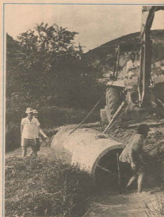
Bueiros. O interior do município na lista das obras
