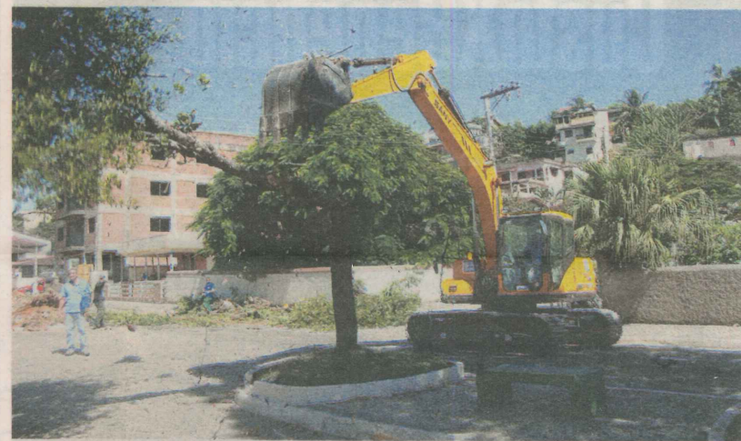
RETROESCAVADEIRA fez trabalho de derrubada na avenida Dom Helvécio
