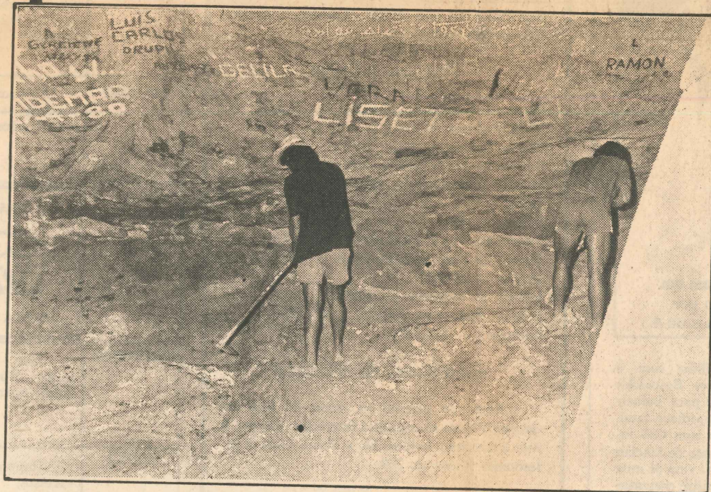
Apesar dos protestos, as obras já começaram.
