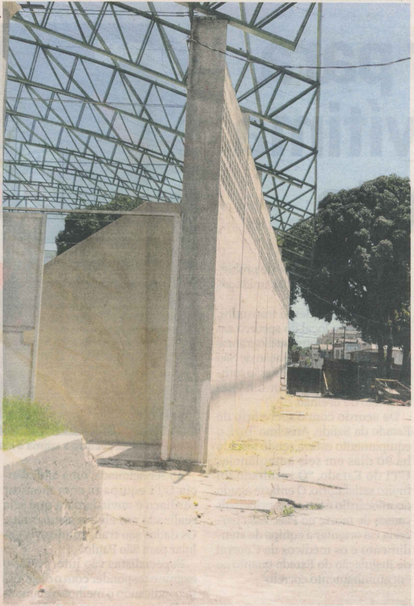
LOCAL que será reformado para oferecer nova área de lazer aos moradores
