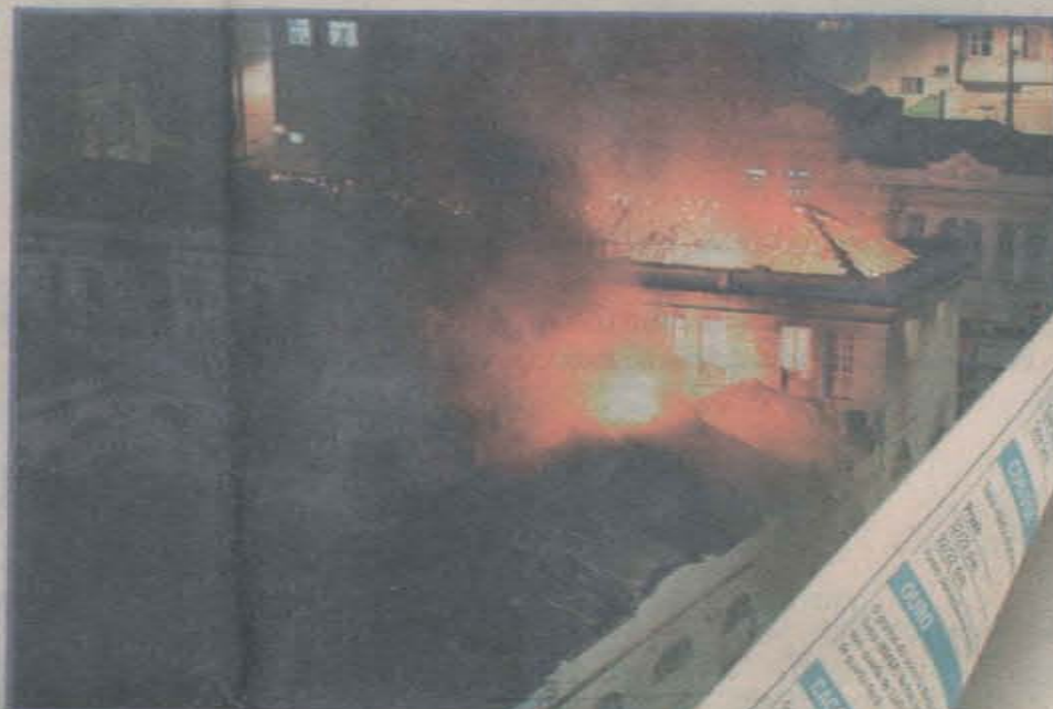
Instaurado em 1928, o prédio do antigo Mercado de Capixaba, do Centro da Vitória, foi destruído pelo fogo.
