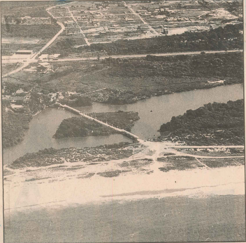
A marina da Barra do Jucu está sendo construída na Ponte da Madalena
