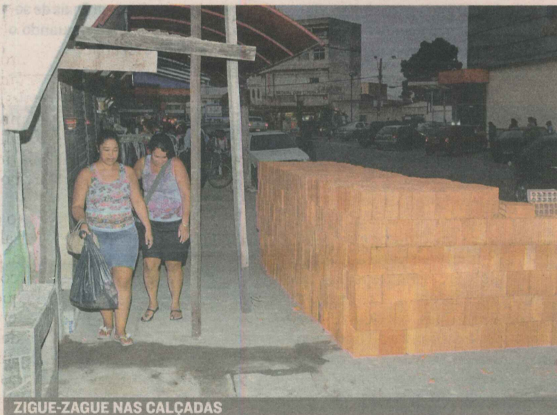
ZIGUE-ZAGUE NAS CALÇADAS
