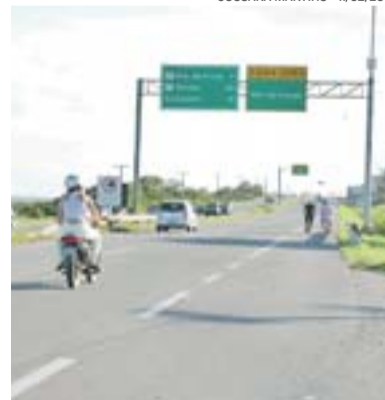
RODOVIA DO SOL: asfaltamento
