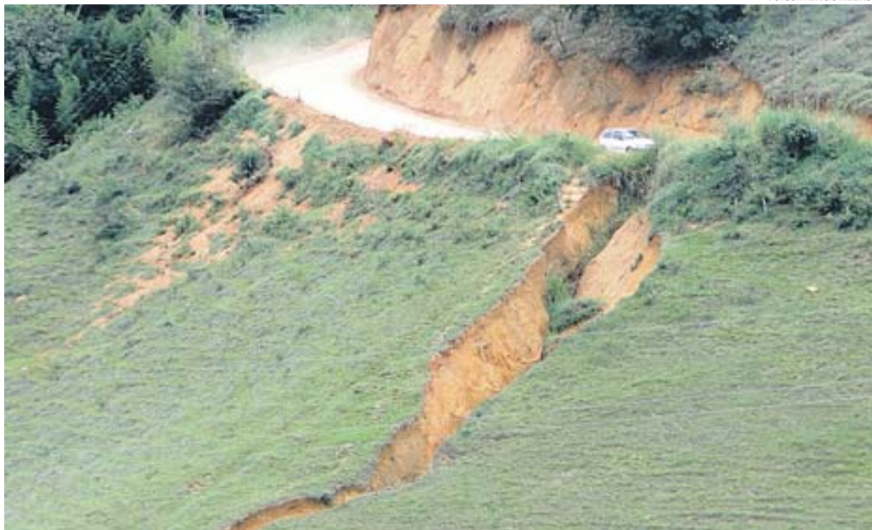
IMPACTO da erosão associada a estrada, pasto e declividade na região de Rio das Pedras, em Santa Maria de Jetibá
