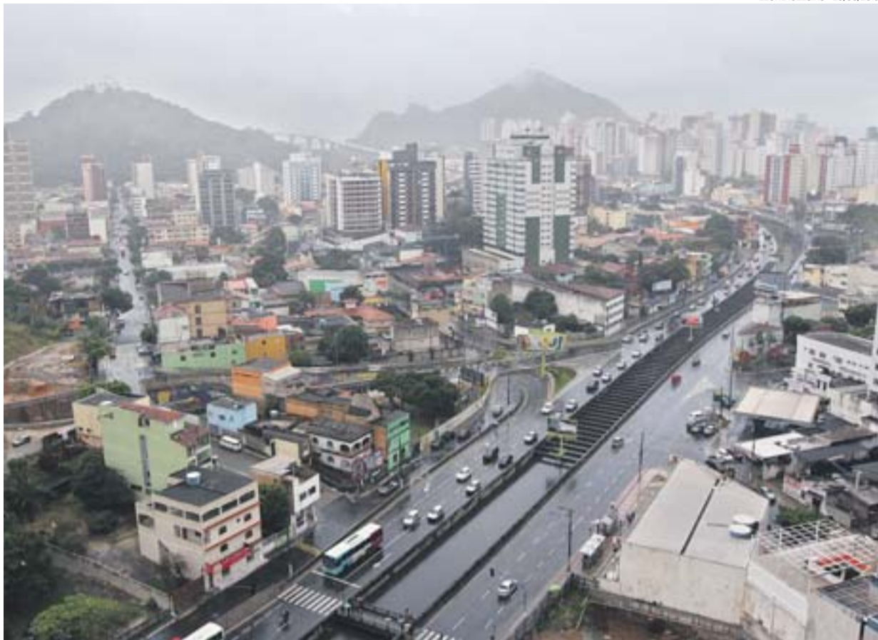
VISTA DE VILA VELHA: Plano Diretor Municipal determina regras para construções, como altura de prédios
