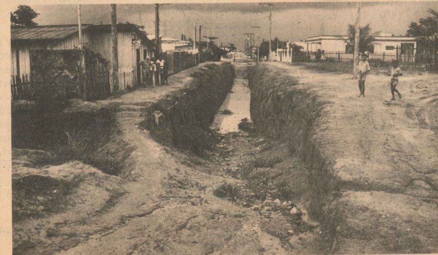
As obras de drenagem começaram mas ficaram pela metade
