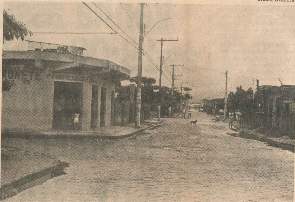
A infra-estrutura prometida pela Cohab até hoje se constitui em expectativa
