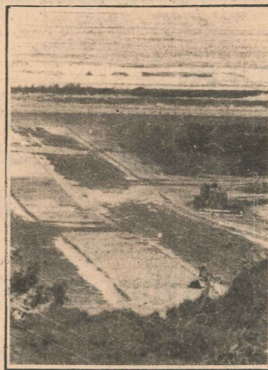
Máquinas urbanizam a área
