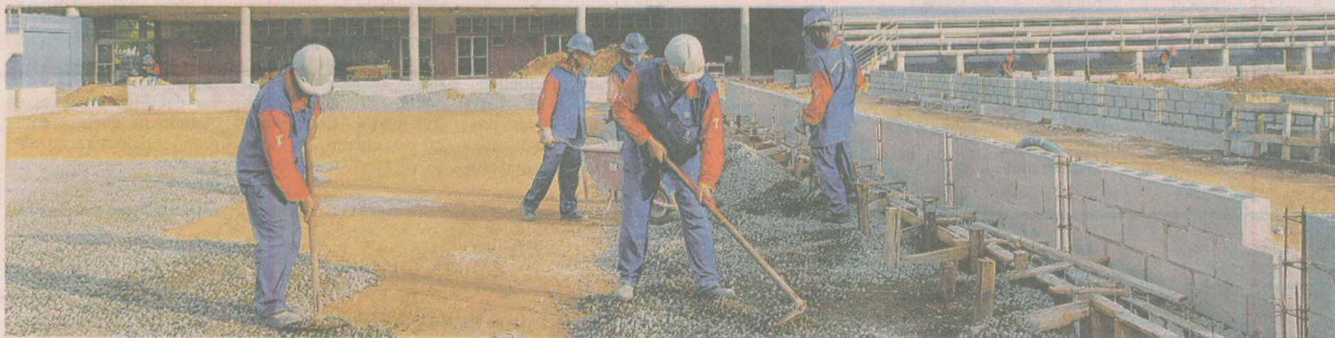
No Parque Tancredão, localizado em Vitória, o reajuste no valor da obra beira os 60%, batendo em R$ 15,3 milhões. A obra termina em setembro. FOTO: VITOR JUBINI
