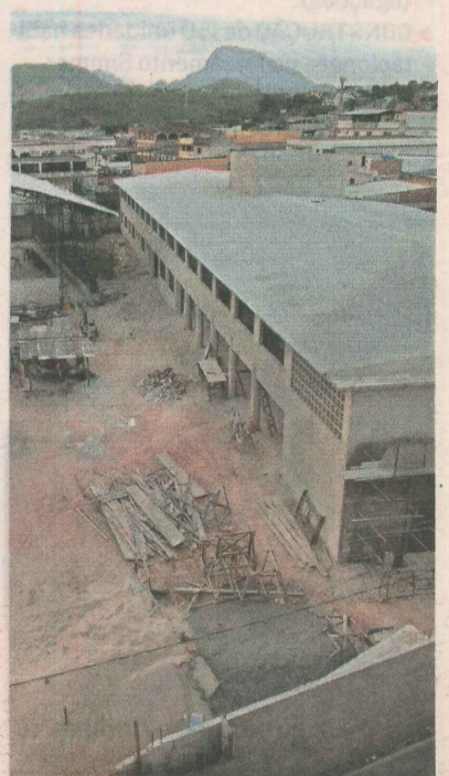
CONSTRUÇÃO de nova escola
