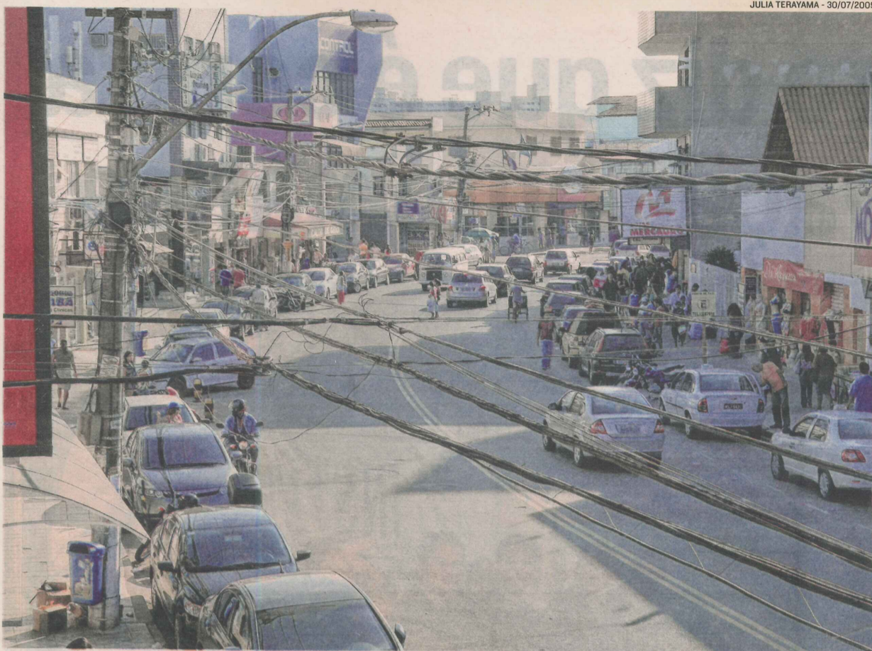
EM AVENIDA de Laranjeiras, a rede elétrica, hoje interligada por fios, será subterrânea, eliminando poluição visual
