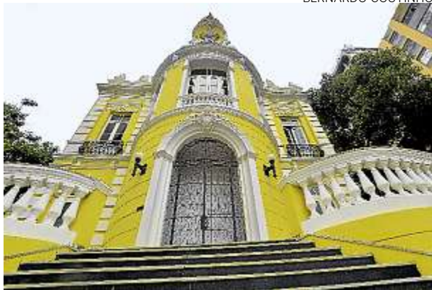
Palácio está sendo reformado e será casa da Ofes
