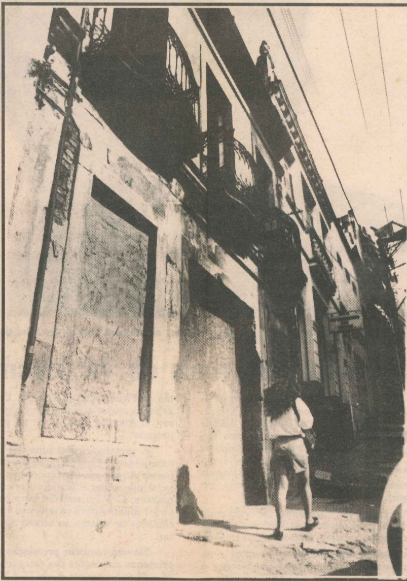
Na rua Duque de Caxias existem vários prédios praticamente abandonados
