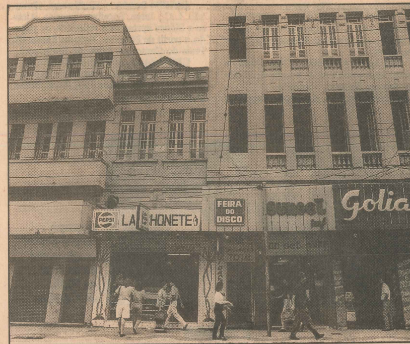
O metal ainda cobre boa parte de imóveis antigos, descaracterizando as casas
