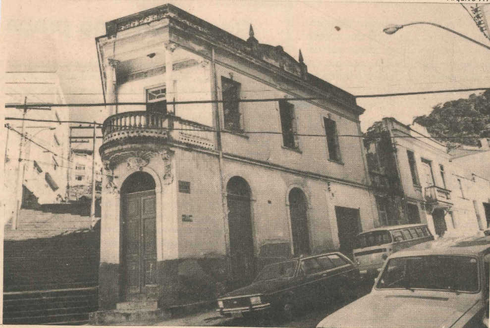
Na Sete de Setembro, um imóvel antigo que poderia ser restaurado
