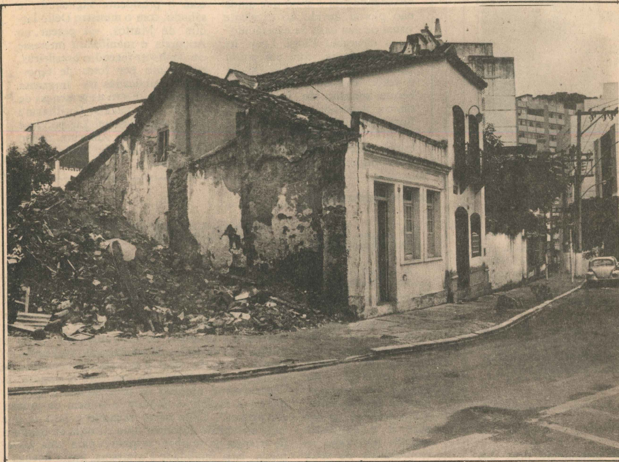
Em 81, a demolição já tinha começado. E parece que não vai parar
