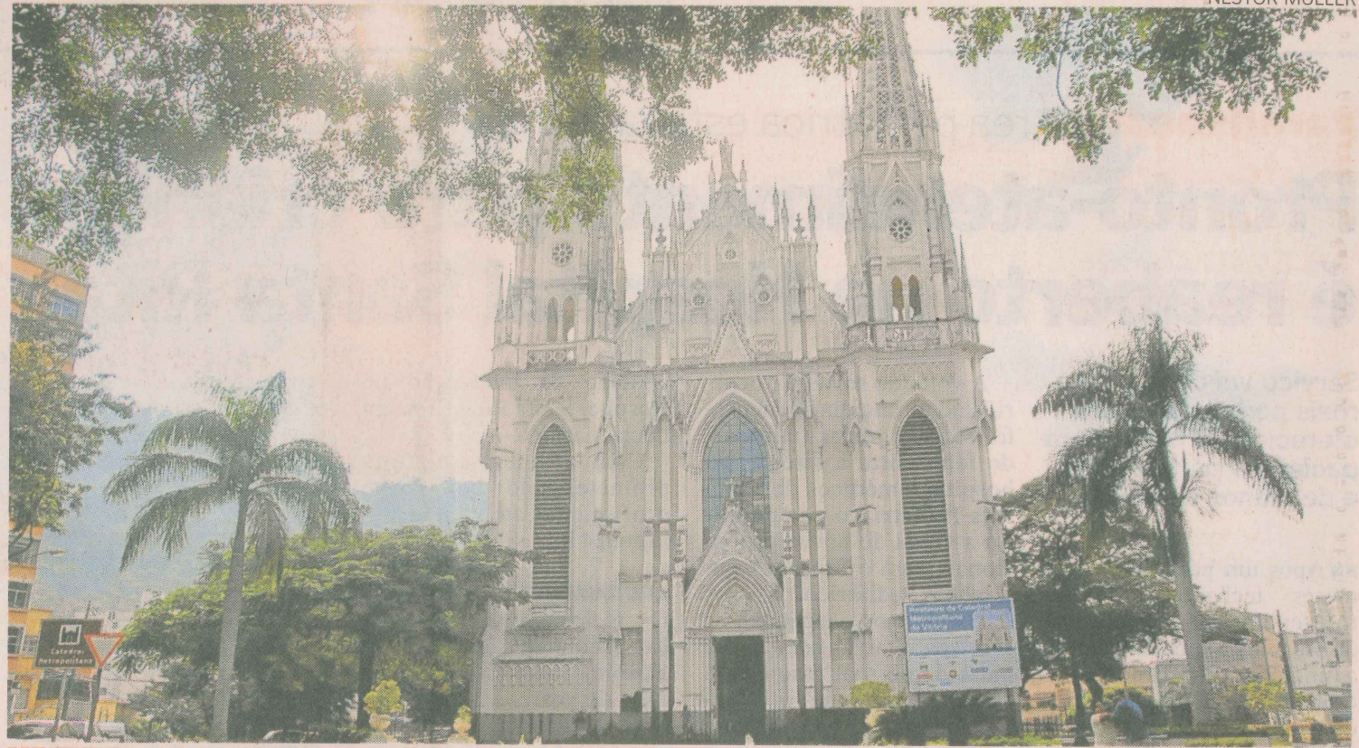
INVESTIMENTO. Projeto de restauração da Catedral vai custar R$ 1 milhão; o valor para execução da obra ainda não foi orçado
