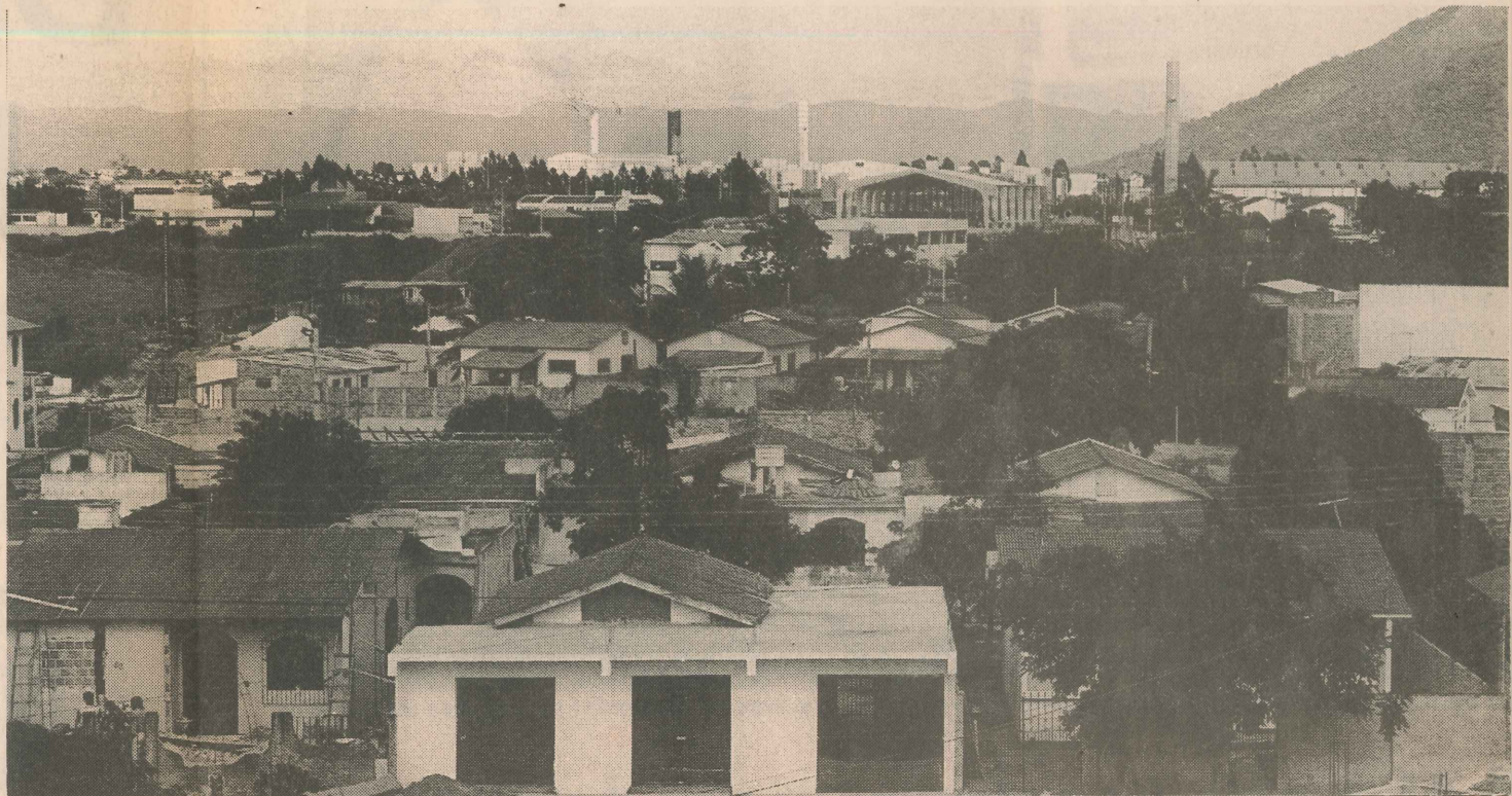
Pouco restou do projeto concebido há 14 anos para o Parque Residencial Laranjeiras, que hoje enfrenta problemas diversos de infra estrutura
