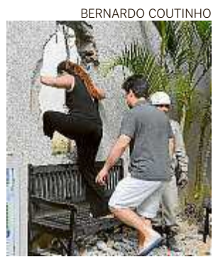
Moradores fizeram buraco para voltar ao prédio
