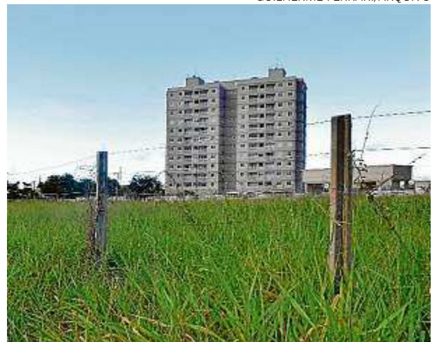
Condomínio Villaggio Manguinhos também é da Cyrela
