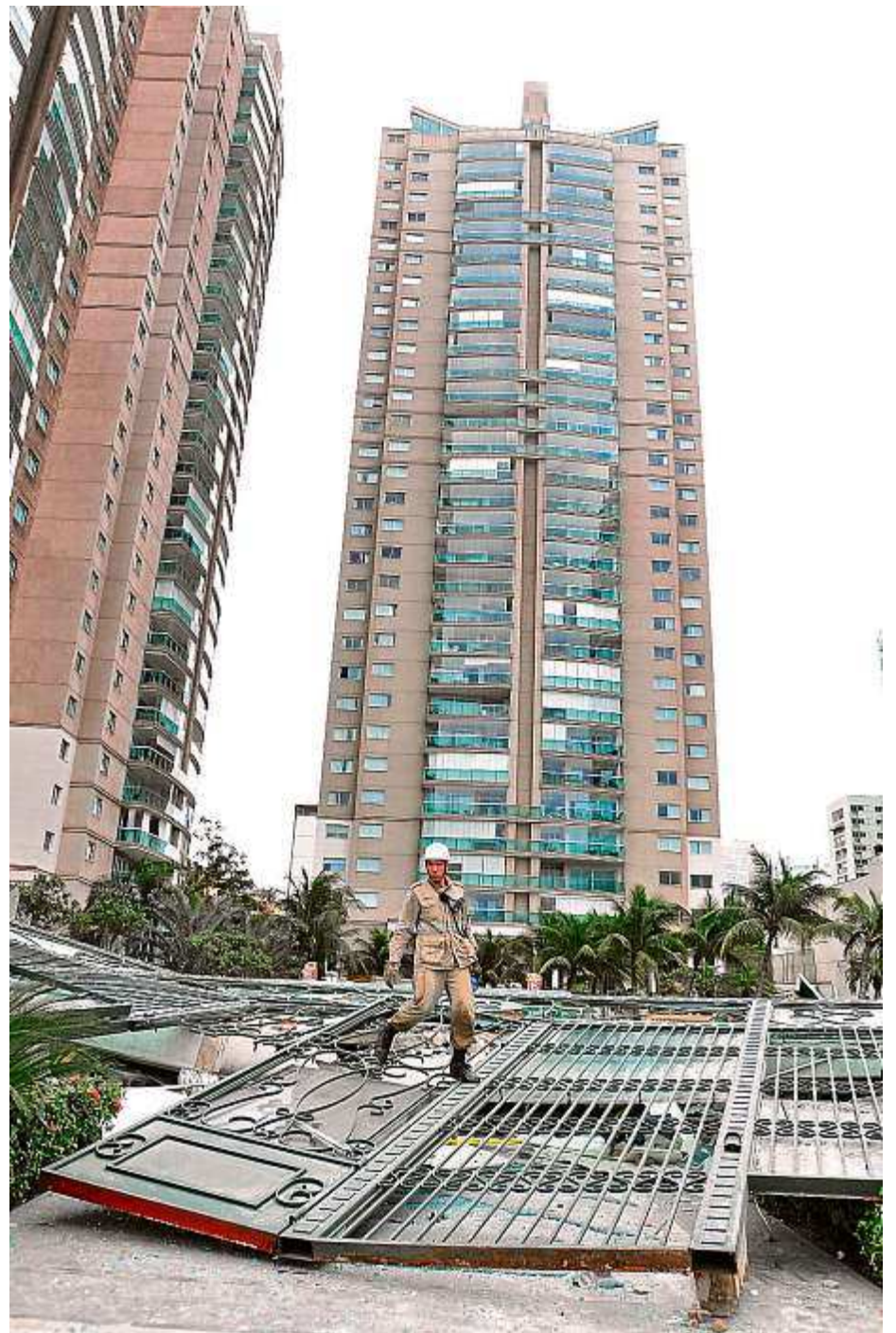
Corpo de Bombeiros foi acionado para ajudar moradores após o desabamento
