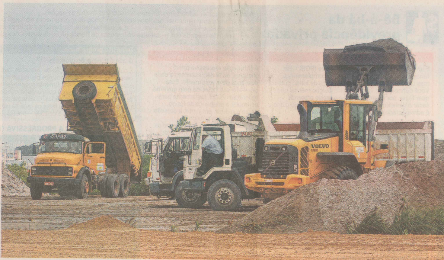
RETOMADA. Ontem, dois trabalhadores faziam medições na nova pista, e três caminhões transportavam materiais. FOTO: CARLOS ALBERTO DA SILVA
