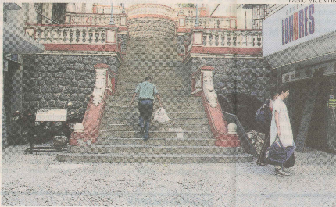
SOB OS PÉS. Um dos tanques de gasolina encontrados ainda está sob a escadaria São Diogo, no Centro
