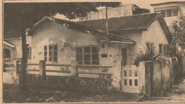
Casa de Homero Massena: promessas de reforma há oito anos
