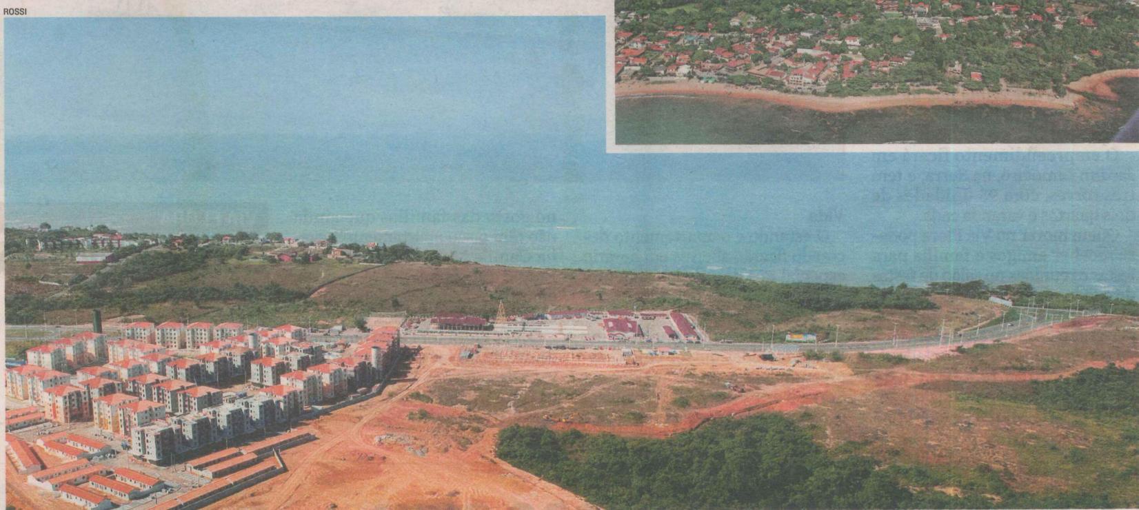
CONDOMÍNIO DE APARTAMENTOS E CASAS em construção na Praia da Baleia é um dos empreendimentos próximos à praia de Manguinhos (destaque)
