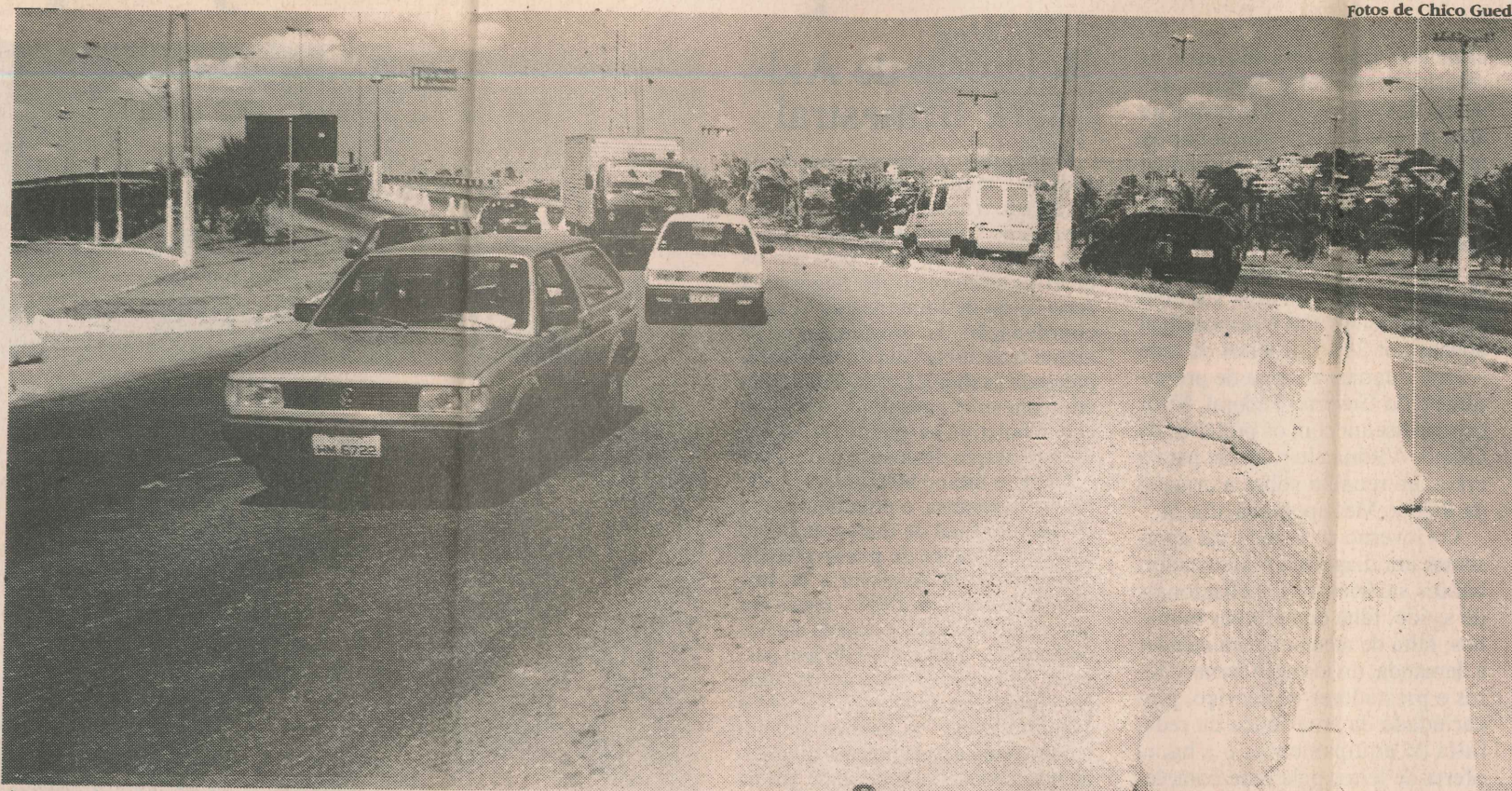
A curva à saída da Segunda Ponte, na Ilha do Príncipe, é das mais perigosas, e motoristas dirigem em alta velocidade, tornando o trânsito caótico
