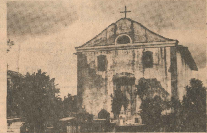
Abandono deixou marcas na antiga igreja de N.Sra. do Desterro.
