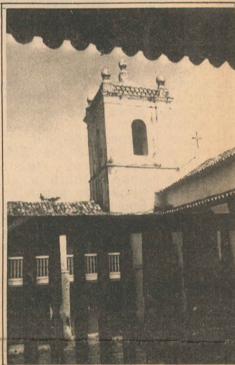
As varandas internas não oferecem qualquer segurança
