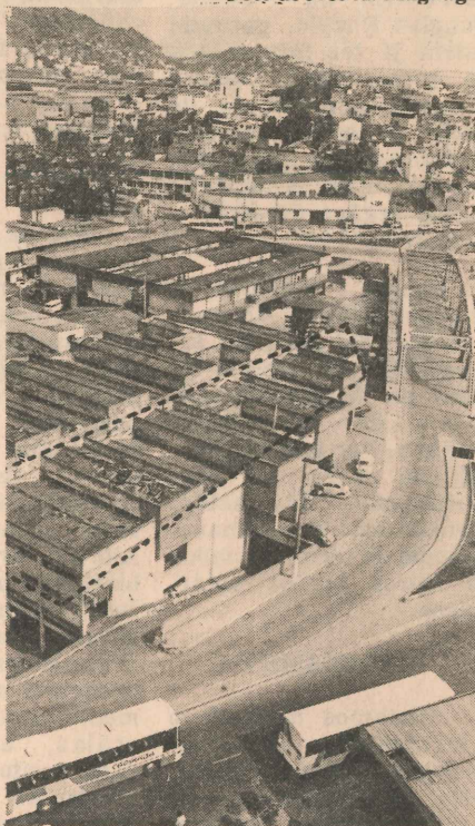
Os prédios pontilhados darão lugar a uma nova avenida na Vila Rubim
