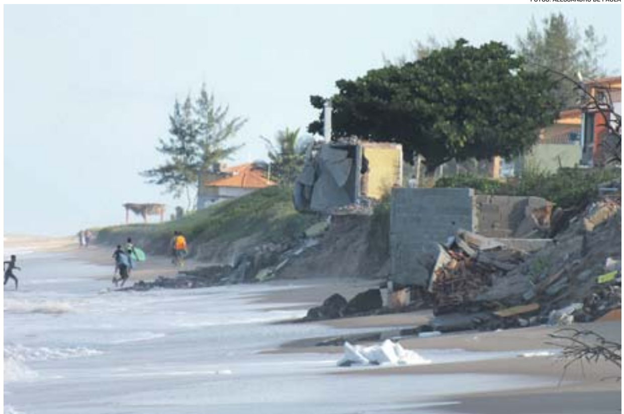
ESTRUTURAS de quiosques destruídos em praia de Marataízes: comerciantes e moradores temem mais prejuízos
